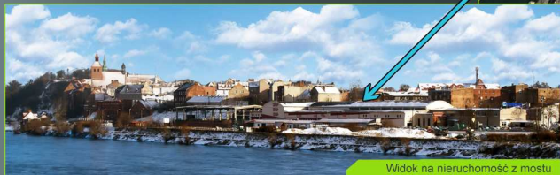
Widok na nieruchomość z mostu
